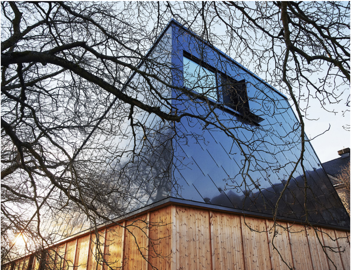
Klimahuset er et av Norges mest miljøvennlige bygg og er ett av forbildeprosjektene hos FutureBuilt. Store deler av taket er dekket av solpanel. Foto: Lars Petter Pettersen/NHM Oslo
