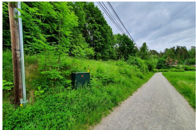
Figur 15. Brønnøyveien 26 på Brønnøya den 7. juni 2022. Foto: Hallvard Elven.
