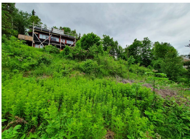
Figur 17. Brønnøyveien 60 på Brønnøya den 10. juni 2022. Foto: Hallvard Elven.
