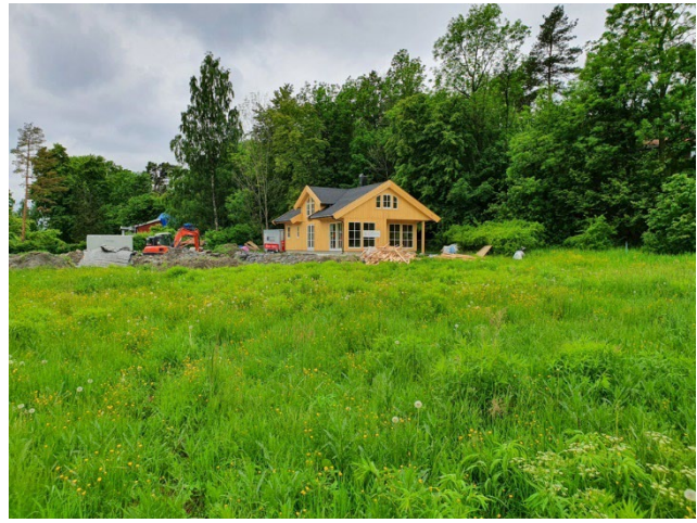
Figur 14. Brønnøyveien 23 på Brønnøya den 10. juni 2022. Foto: Hallvard Elven.
