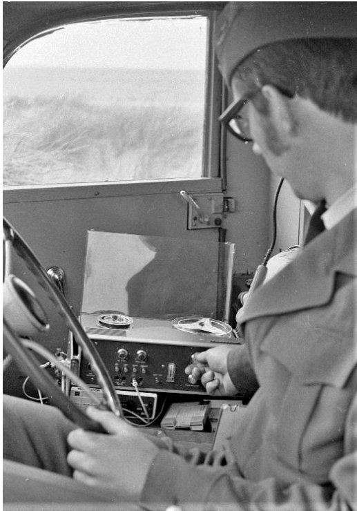
Fig. 12. Utvalgte fuglearters alarmskrik/varselskrik tidligere opptatt på bånd, ble avspilt fra en båndopptaker i fuglebilen koblet til en vribar høyttaler på bilens tak (se Fig. 5). Fotoet av forfatteren er tatt av Gunnar Lid.
